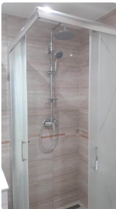
Rekonštrukcia bytového jadra a kuchyne Stavby Šimunek
