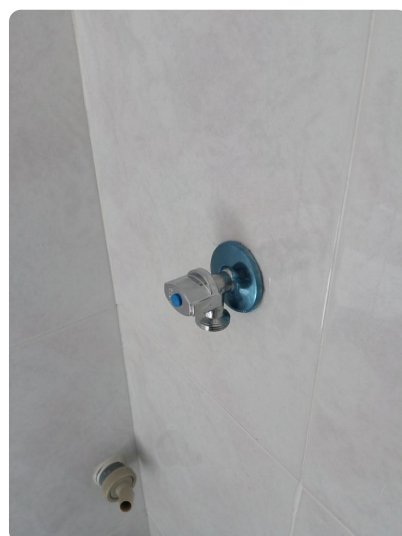
Instalacion toma de agua para lavadora
