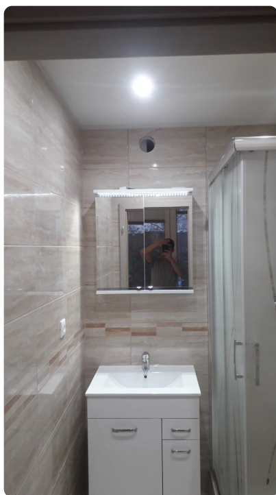
Rekonštrukcia bytového jadra a kuchyne Stavby Šimunek
